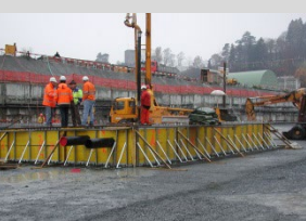
Top-Form S1 im Einsatz mit Abschalstütze AST SK
